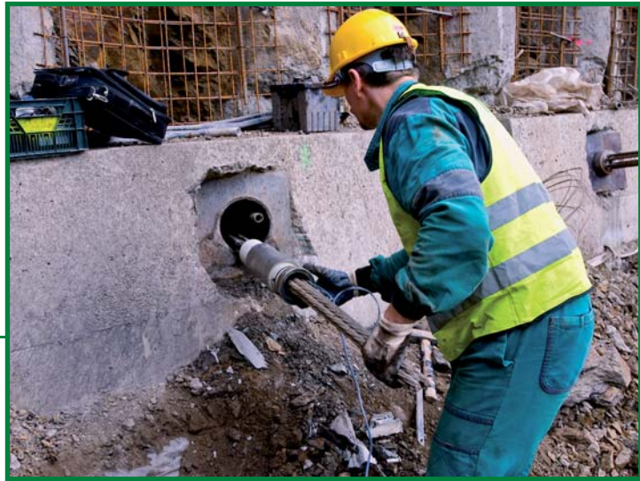
instalace snímače na zemní kotvu
