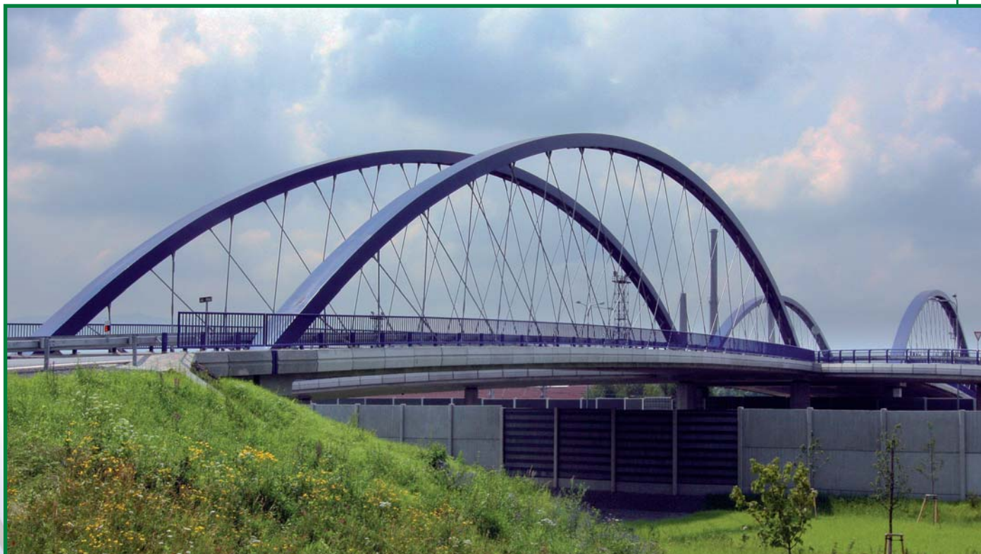
monitorované mostní objekty v Třinci-Balinách
