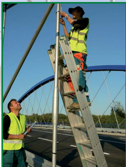
instalace induktivního dynamometru INDY
