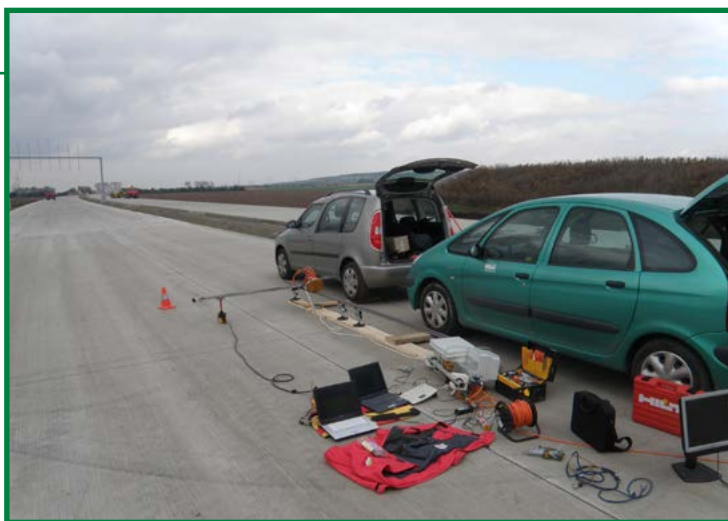
určování přesné pozice kluzných trnů a kotev ve vozovce
