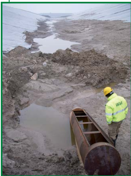
kontrola odvodnění úložného prostoru
