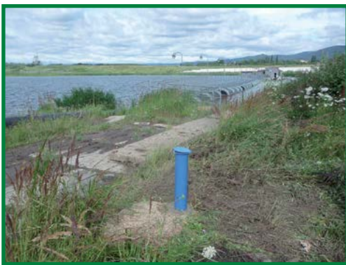
hydrogeologická sonda
