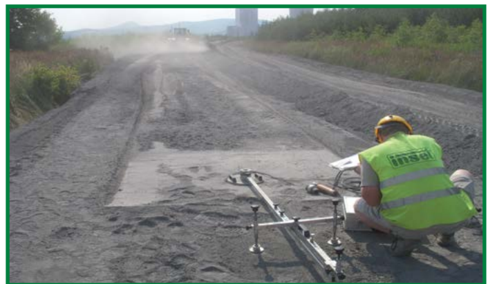
statická zatěžovací zkouška
