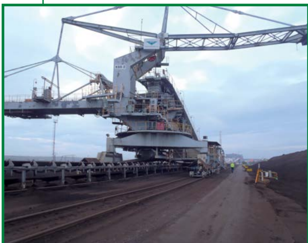
měření deformací kolejových drah
