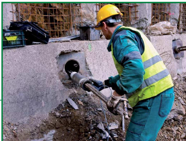
instalace snímače na zemní kotvu
