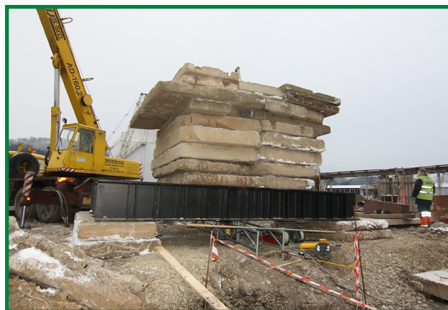
zatěžovací konstrukce tvořená protiváhou
